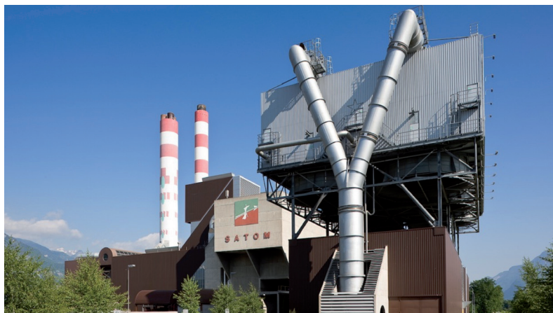
Usine de traitement des ordures – SATOM, Monthey (Valais/Suisse)
